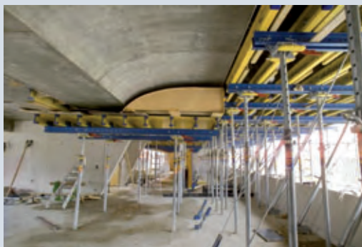
Für die innen verlaufenden, asymmetrischen Vouten wurden Aufdopplungskästen im gewünschten Fugenraster verwendet.
