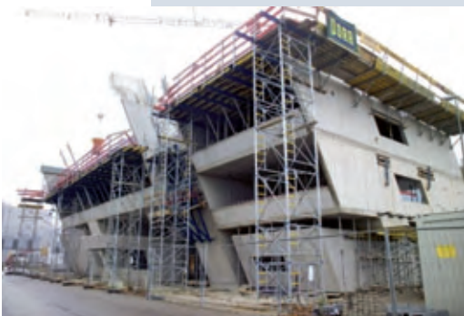
Das um 26° nach Süden geneigte Verwaltungsgebäude kommt durch auskragende Schaltische fast völlig ohne Traggerüste aus
