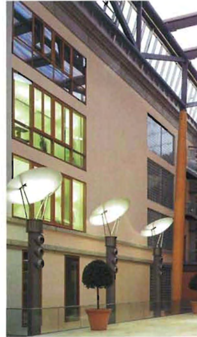
Die Piazza wird durch 8 m hohe Stele belüftet. Diese Elemente wurden gleichzeitig als Reflektoren ausgebildet
